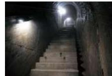
鮎屋川ダム(堤体内)
